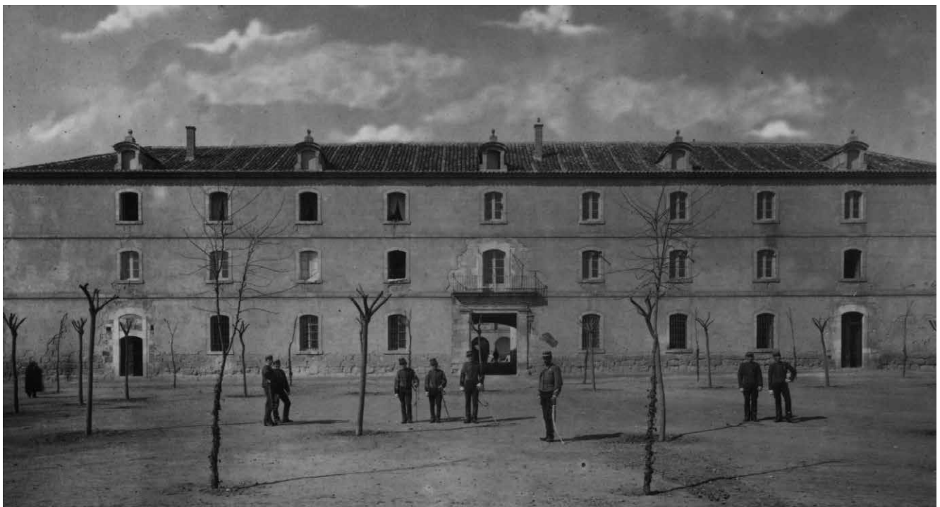
Fachada del cuartel de infantería de Zamora, sede de la AES
