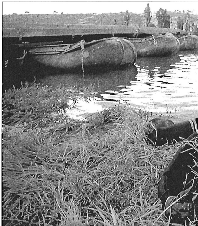
Instalar y asegurar militarmente un puente flotante, con casi cien metros de longitud, es una c
