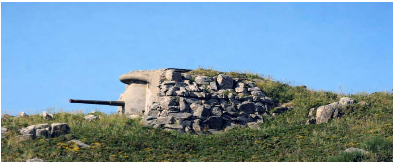
Baterías de costa en Cabo Silleiro, Galicia. Fuente: https://www.tracesofwar.com/sights/90684/Vickers-1524-50-Gun.htm
