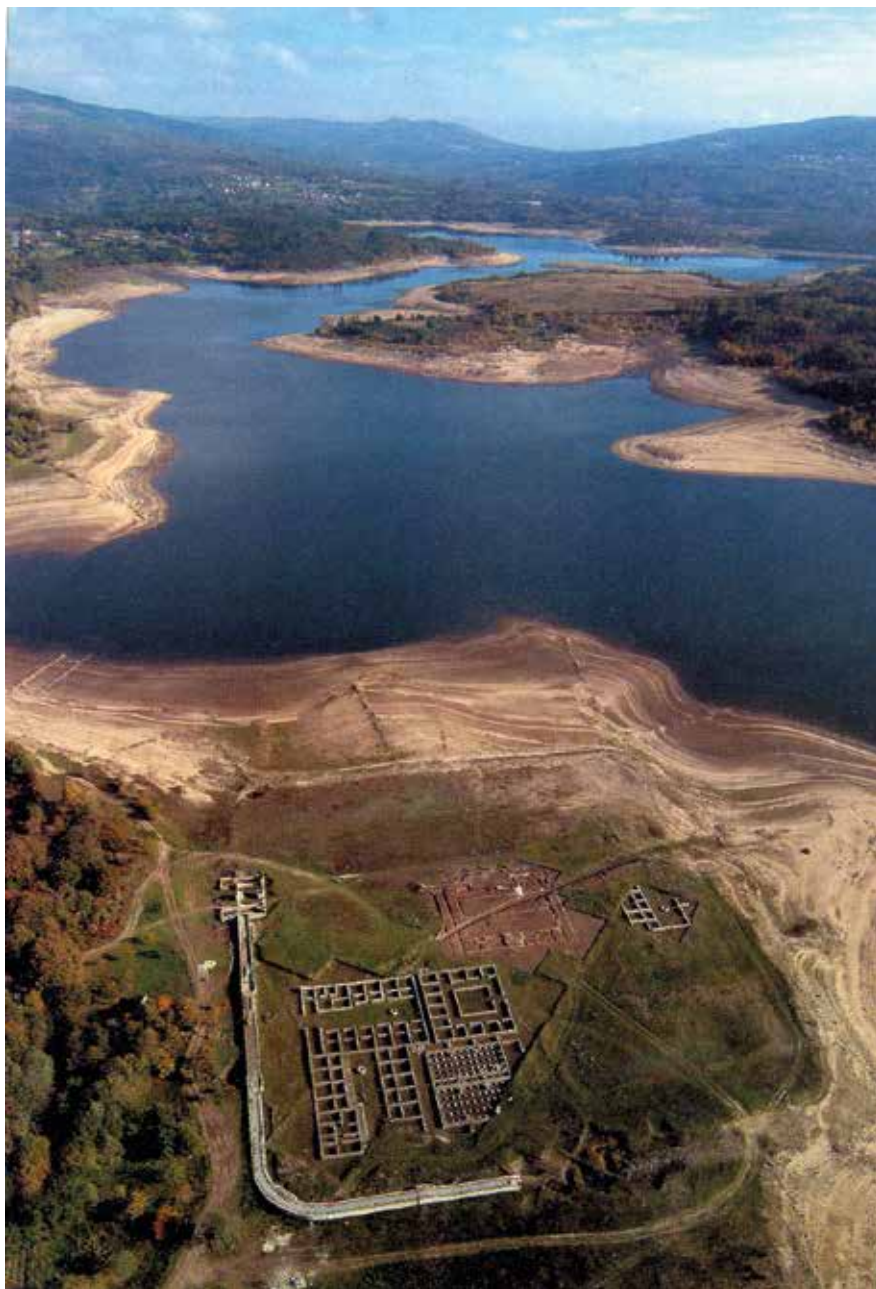
Fig. 59. Fotografía aérea del campamento de Baños de Bande (Aqua Querquennae) (A. Rodríguez Colmenero y S. Ferrer)
