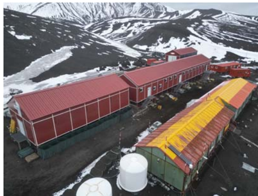
Vista desde el NE, parcialmente oculto tras el almacén.
