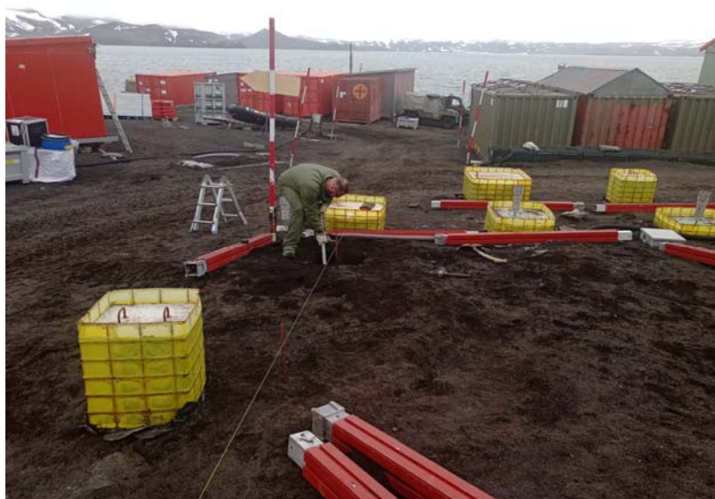
MING: Montaje y ensamblaje de placas base y preparación de paneles.
