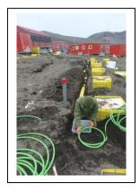
Zanjeado de acometida red eléctrica para el futuro módulo científico. Se han colocado dos arquetas y realizado la tirada. Conectada al cuadro general del G.E queda preparada para cuando se instale el
