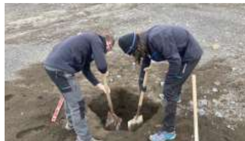
ADECUACION DE TERRENO PARA AEROGENERADOR
