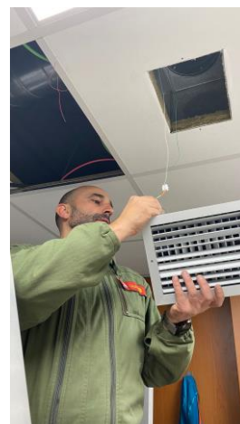
TRABAJOS EN MODULO DORMITORIO
