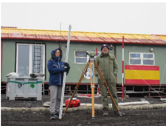
NIVELACION DE MARCAS DEL MURO
