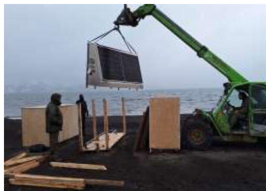
PREPARACION CASETAS IGN
