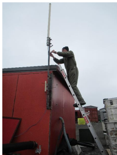
TRABAJOS ADECUACION DE ANTENA
