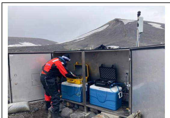
REVISION DE EQUIPOS EN OBSIDIANAS
